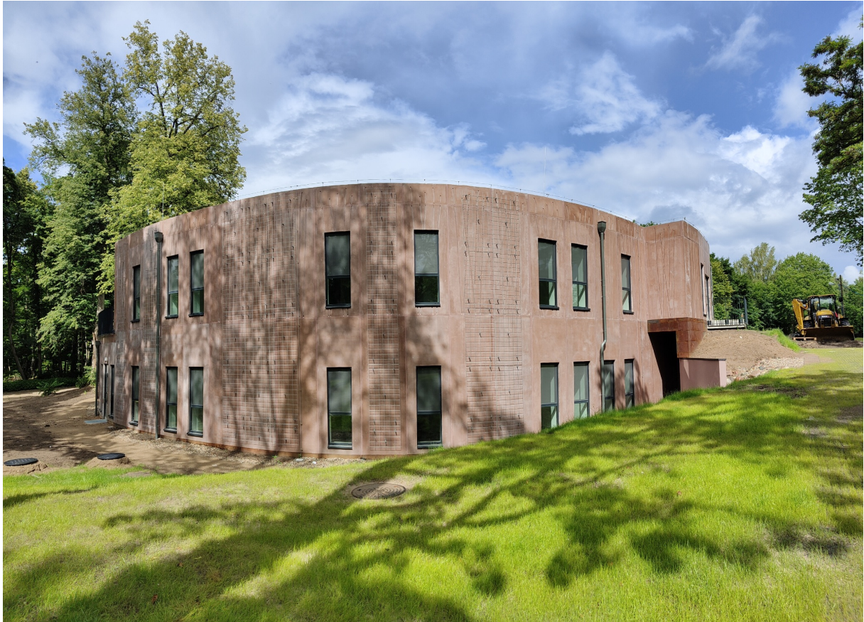
Ryc. 10. Budynek badawczo-dydaktyczny centrum KUMAK Urwitałcie.
